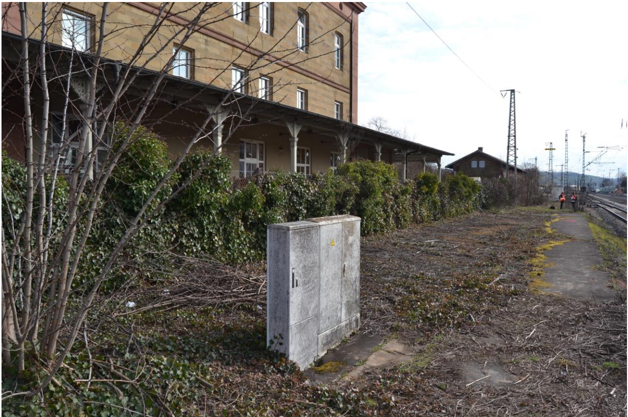
Abb.08: Baufeld Gleis 1 NSHV DB Energie (Außenbahnsteig)
