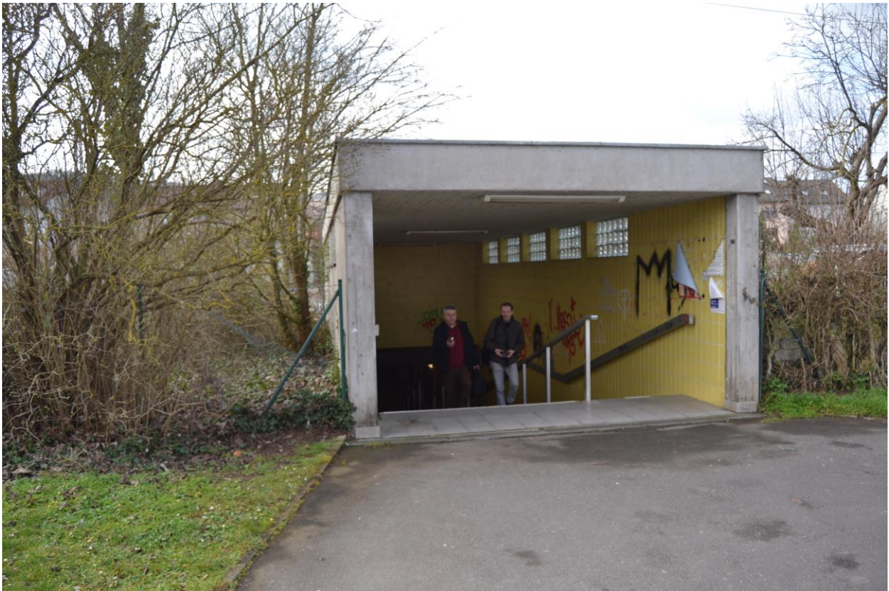
Abb.04: Einhausungen Treppenaufgang Nordseite
