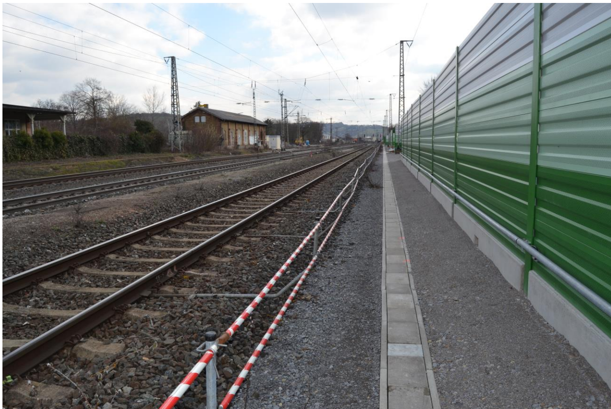
Abb.10: Baufeld Gleis 3 (Blickrichtung Treuchlingen)
