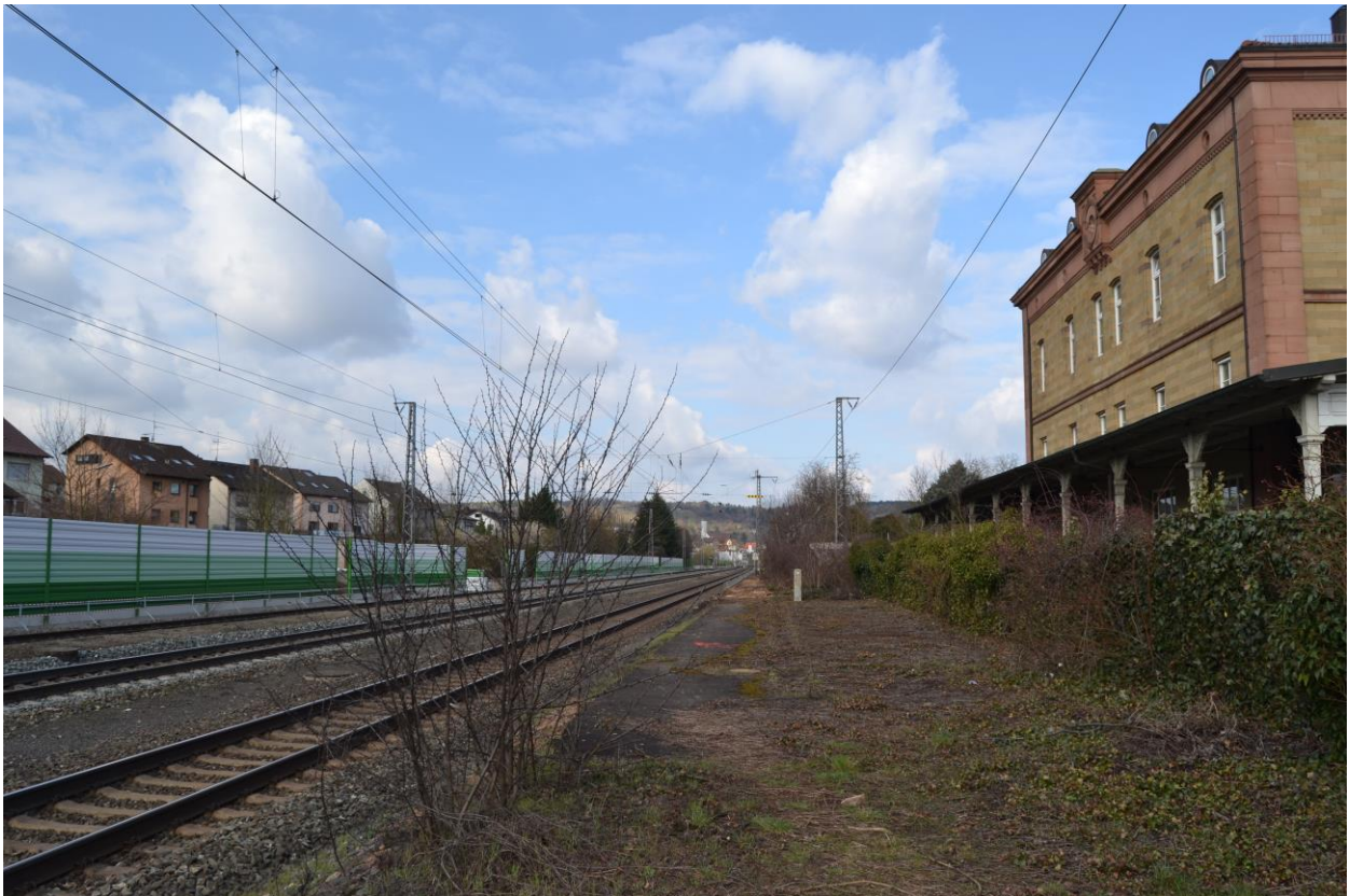
Abb.06: Baufeld Gleis 1 (Außenbahnsteig)
