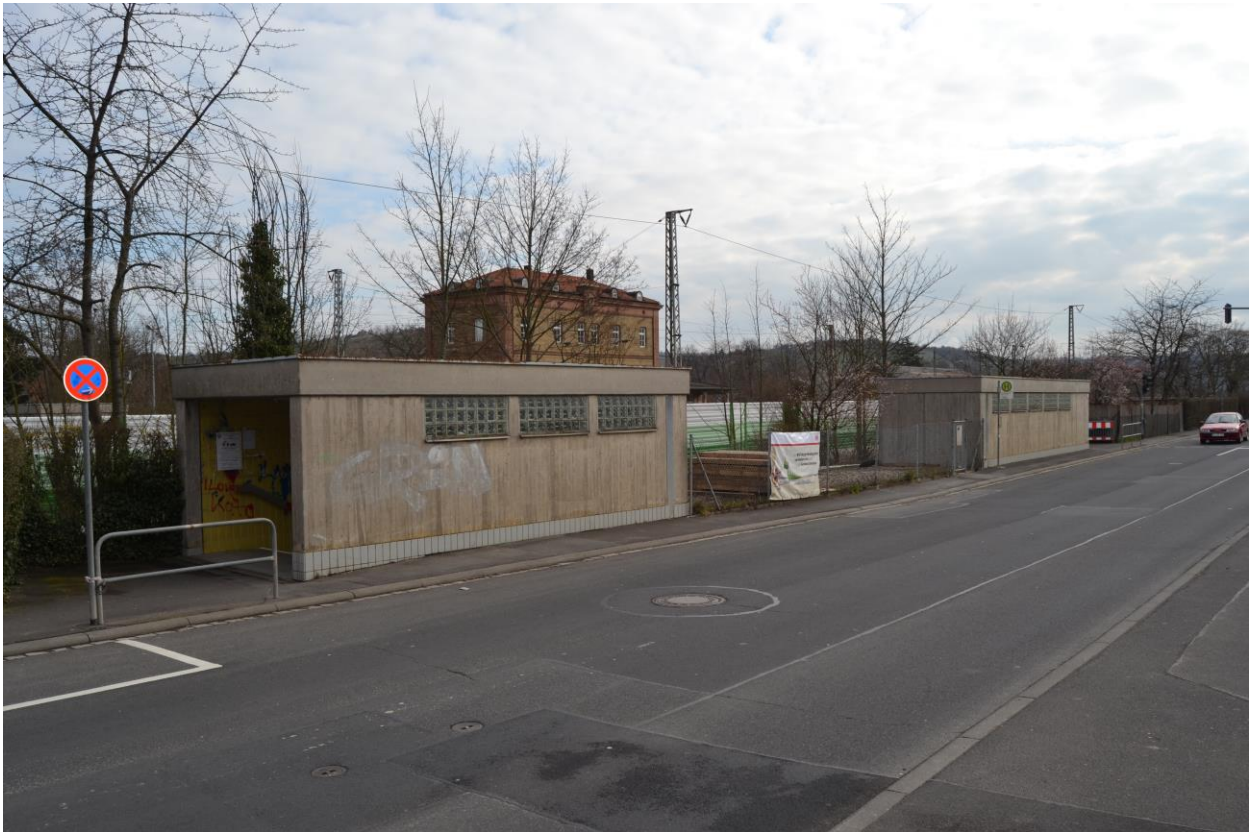
Abb.01: Einhausungen Treppenaufgänge Südseite
