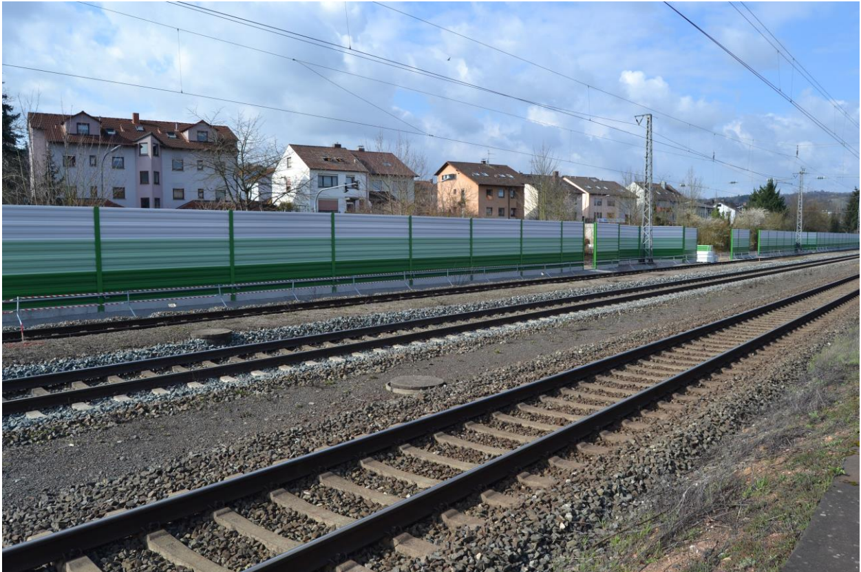
Abb.07: Baufeld Gleis 2 / 3 (Inselbahnsteig)
