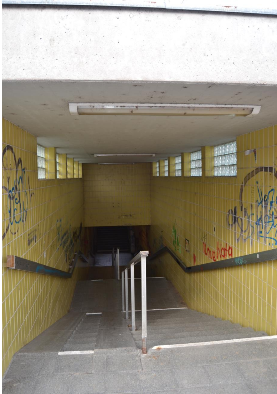
Abb.02: östlicher Treppenaufgang Südseite
