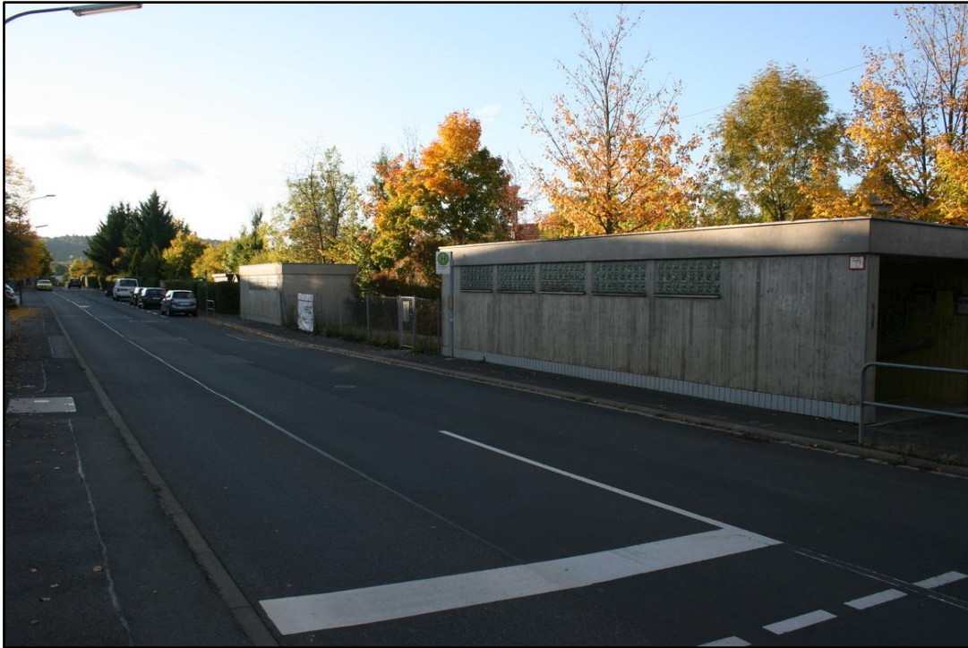
Abbildung 4: Südausgänge der PU mit dahinterliegenden Baumbeständen. Siehe Tab. 1, Nr. 5 a&b (Foto: Inros Lackner SE)
